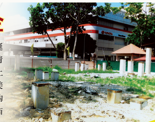
新庙地基工程已经完成
